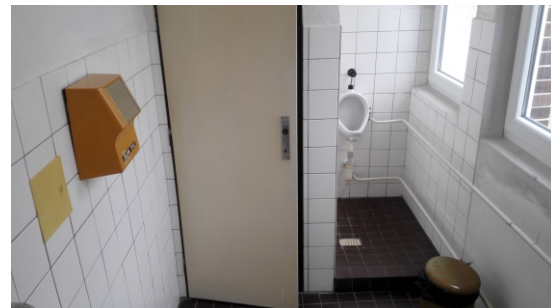
Rekonštrukcia sociálnych zariadení pre pacientov na I. poschodí v budove zdravotného strediska - pôvodný stav.
