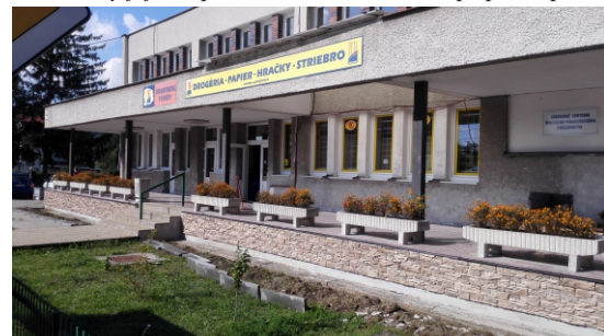
Po viac ako tridsiatich rokoch prevádzky si financie na opravy pýta i budova zdravotného strediska. V exteriéroch boli obnovené sokle.
