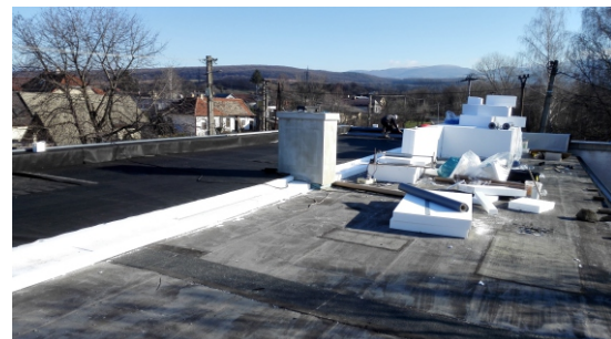
Havarijný stav strechy budovy hasičskej zbrojnice bol odstránený jej komplexnou rekonštrukciou - príprava prác.
