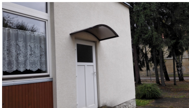
Tri takéto prístrešky boli namontované na budove domu kultúry a jeden na budove hasičskej zbrojnice. Ich účelom je chrániť vchodové dvere a minimalizovať možnosti zatekania do budov počas privalových dažďov.
