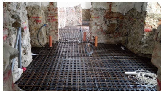
Časť interiéru barokovej kúrie vedľa kaštieľa - príprava odvetraných podláh pred uložením betónových podláh.
