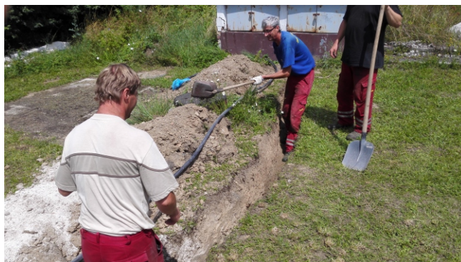
Ukladanie kábla do ryhy pri budovaní novej prípojky elektrickej energie na futbalovom ihrisku.
