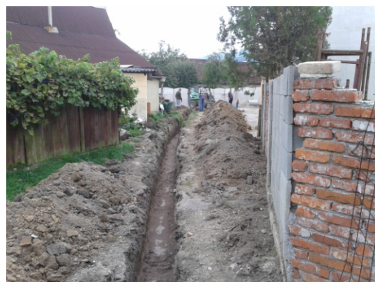
Výkop odvodňovacieho kanála za účelom realizácie stavby „Odvodnenie záhrad na ulici J.Hagaru“.
