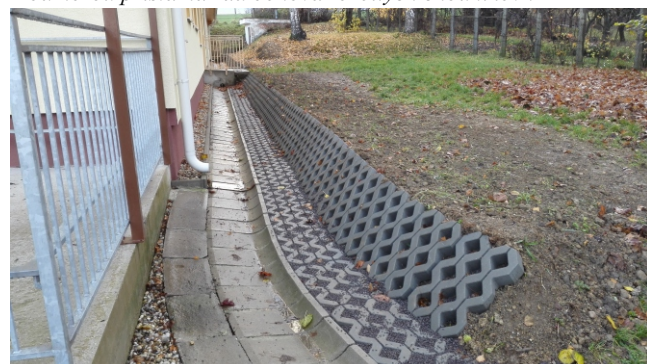
Spevnenie svahu v novej časti dvora materskej školy.
