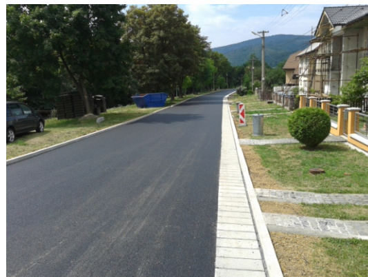
Uloženie obrúb, odvodnenie a nový asfaltový povrch na miestnej komunikácii na ulici Boženy Němcovej (nad hasičskou zbrojnicou).
