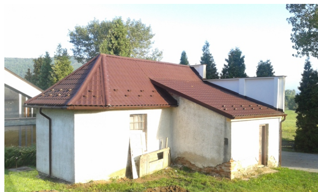
Na miestnom cintoríne bola okrem rozšírenia urnového hája zrealizovaná rekonštrukcia strechy a južnej rímsy na starom dome smútku.
