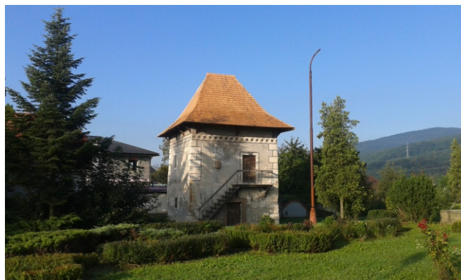
Výmena šindľovej strechy na Sýpke v súlade so záväzným stanoviskom Krajského pamiatkového úradu Trenčín.
