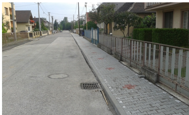
Letné mesiace boli vhodným obdobím na rekonštrukciu časti chodníka, ktorý bol v najnevyhovujúcejšom technickom stave.
