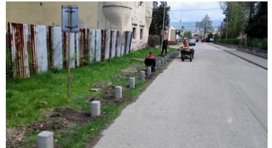
Osádzanie betónových zábran za účelom obmedzenia parkovania vozidiel na verejnej zeleni.
