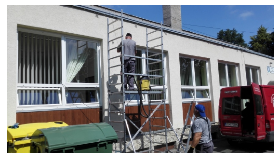
Montáž klimatizácie do priestorov obecnej knižnice, čítárne a kancelárskych priestorov domu kultúry.
