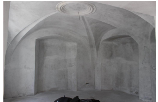
Časť interiéru barokovej kúrie vedľa kaštieľa - základná úprava omietok.
