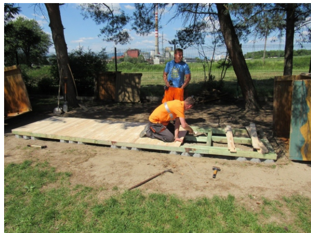
Ján Schvandtner a Andrej Adamko montujú novú podlahu v domčeku.
