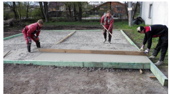
Zamestnanci obce pri prácach na príprave podkladovej dosky na dve montované garáže.
