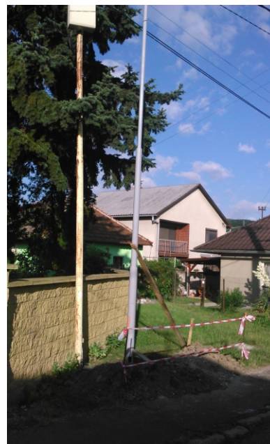
Dodávateľ začal s opravou stĺpov miestneho rozhlasu na Ulici Boženy Němcovej. S opravou súvisí aj prekládka vedenia miestneho rozhlasu a káblovej televízie na nové alebo zrekonštruované stĺpy.
