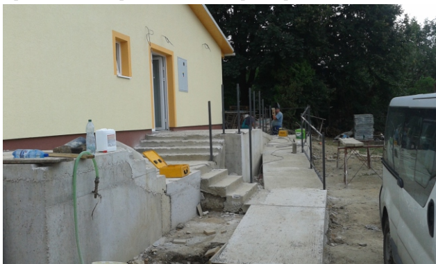
Práce na rekonštrukcii - rozšírení materskej školy.
