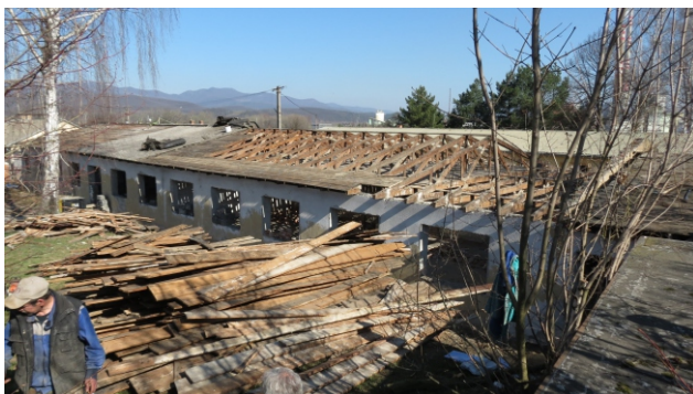
Odkrývanie krovu počas realizácie prác „Rekonštrukcia materskej školy“.
